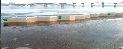
Десантированное из самолета Ил-76ТД боновое заграждение. р. Волга, г. Кострома
