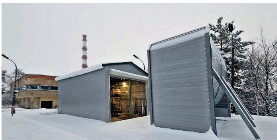
Винтомоторный стенд для испытаний АПД, введенный в эксплуатацию в 2022 г.
